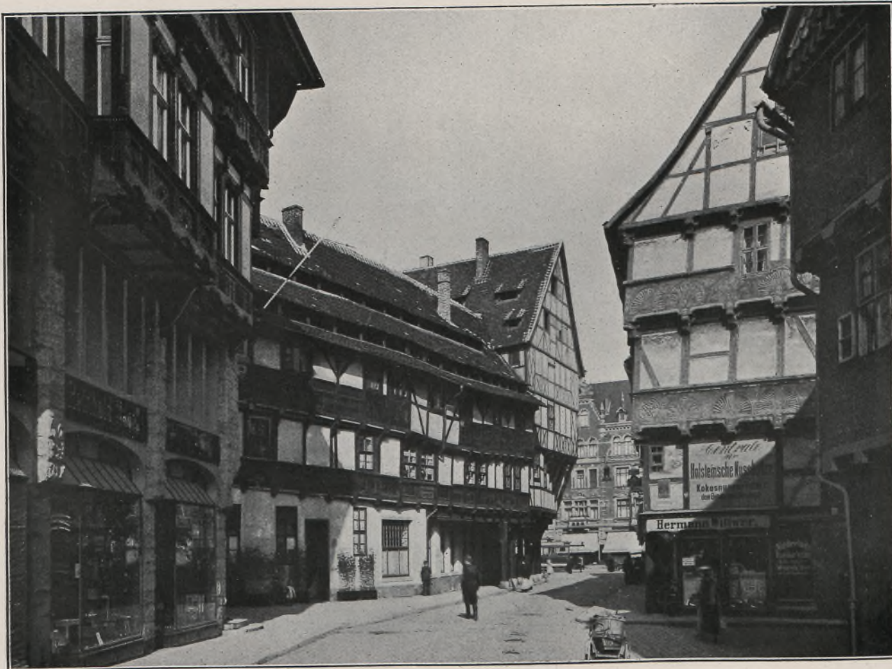
a) Eckhaus am Fischmarkt in Halberstadt, b) Straße „Hinter dem Richthause“ in Halberstadt nach Verbreiterung der Straße.
