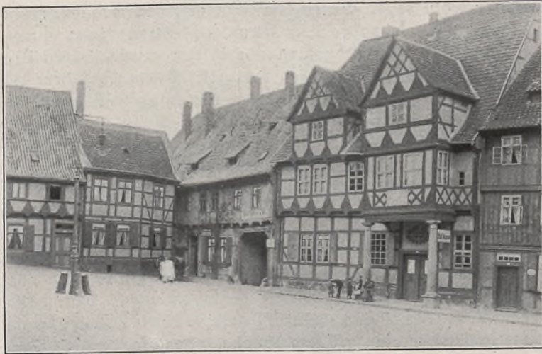
Abb. 9. Platz des Schloßberges in Quedlinburg.
