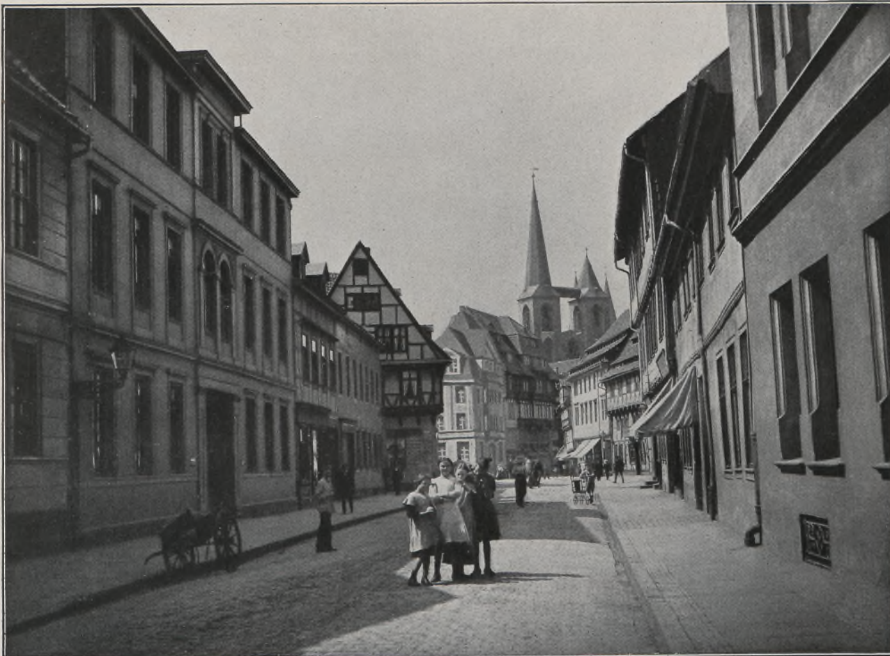
Ecke der Straße „Hinter dem Richt- hause“ in Halberstadt nach der Straßen- verbreiterung.
