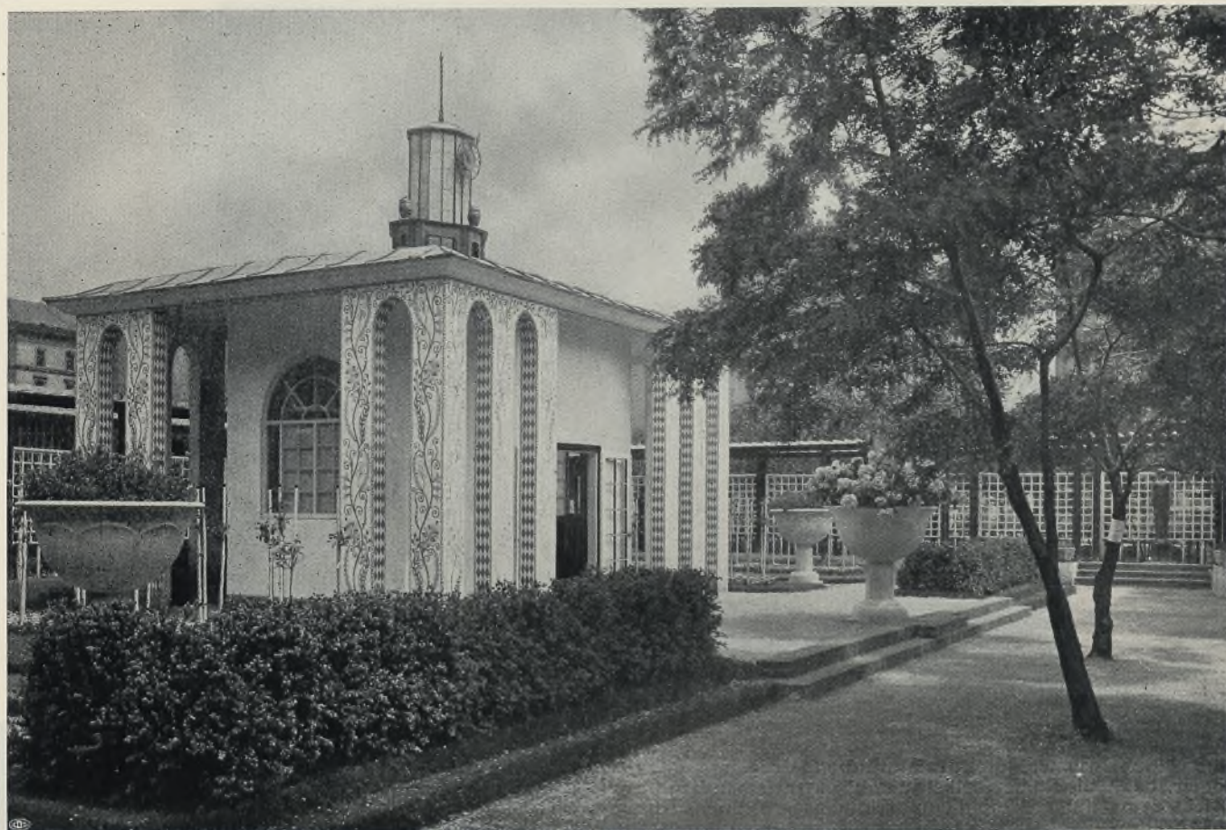
Parkhaus. Architekt Ernst Lichtblau. Aus dem Garten der Frühjahrsausstellung österr. Kunstgewerbe in Wien 1912
