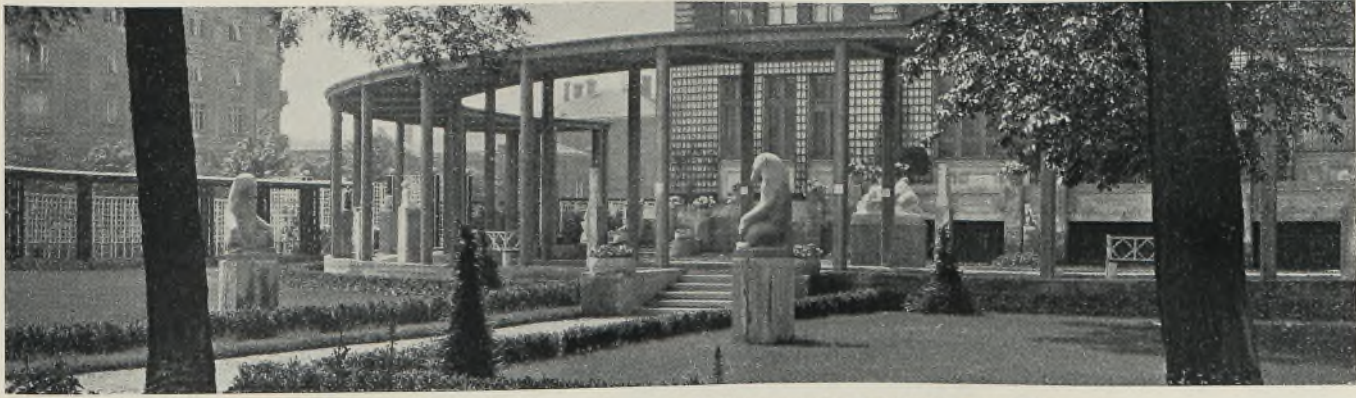
Kolonadengang in der Frühjahrsausstellung österr. Kunstgewerbe. Architekt Caesar Poppovits Ausführung in Eisenbeton von Westermann & Co. in Wien
