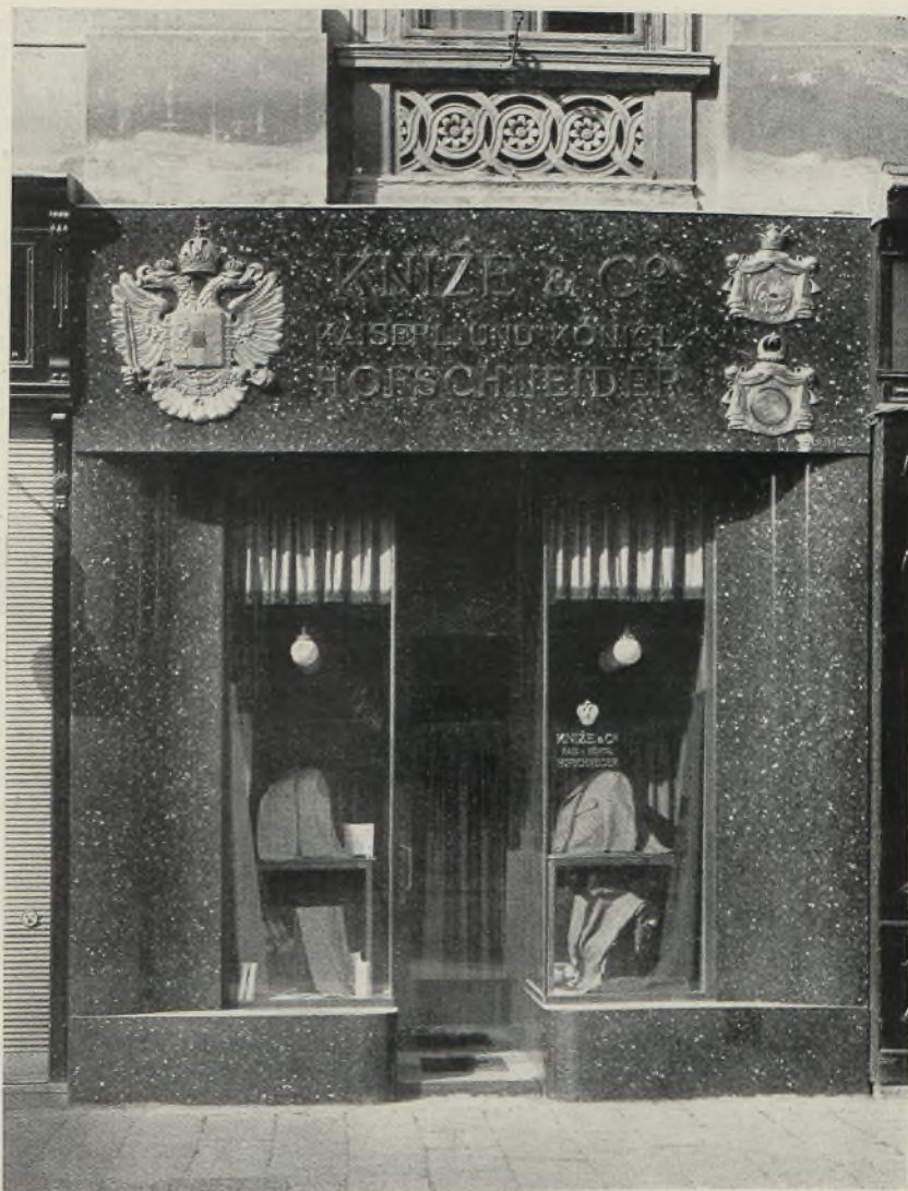
Portal in Wien I. Entwurf: Architekt Adolf Loos in Wien
