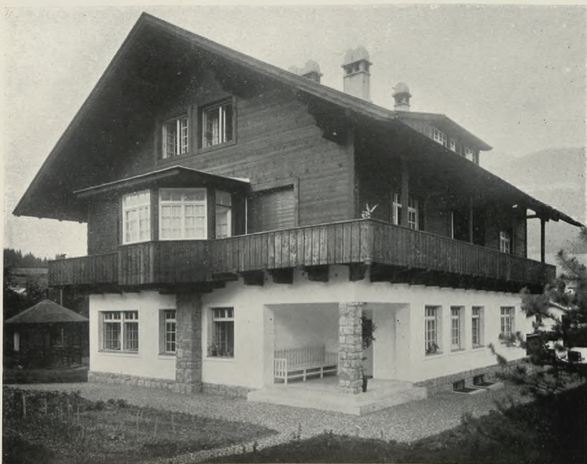
Wohnhaus R. in Kitzbühel
