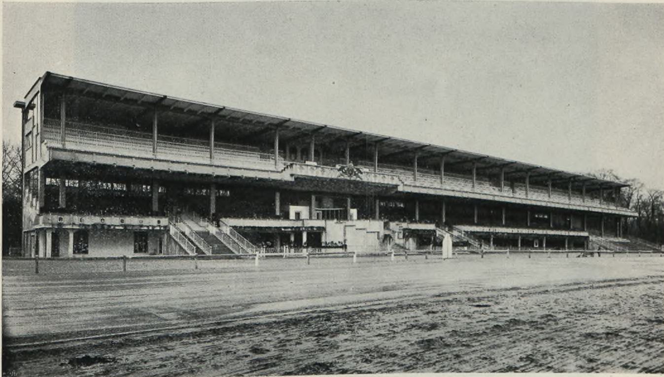
Tribüne des Wiener Trabrennvereines. Gesamtansicht. Entwurf: Architekten E. Hoppe, M. Kammerer und O. Schönthal Eisenbetonarbeiten: E. A. Westermann & Co.
