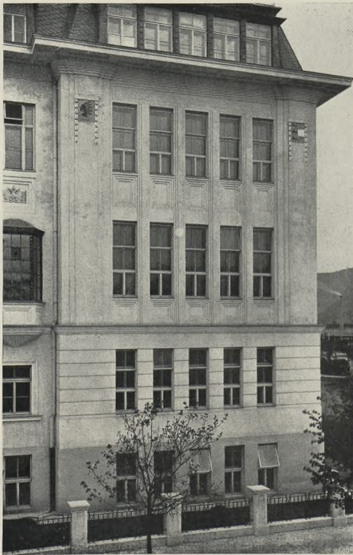
Neubau der k. k. Bau- und Kunsthandwerkerschule in Villach (siehe Tafel 81). Architekt Leopold Führer in Villach
