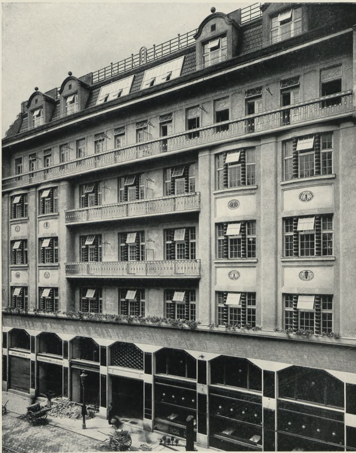
Wohn- und Geschäftshaus in Wien VII
