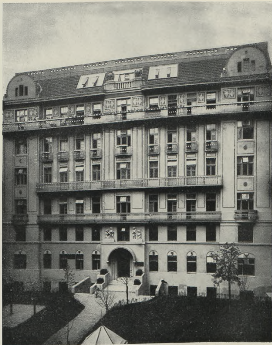
Rückgebäude des Hauses auf Tafel 74. Architekt Hans Prutscher
