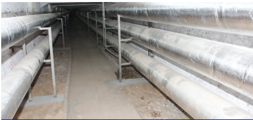
Wrzesień 2011 - kanał ciepłowniczy pod krytą bieżnią po modernizacji
