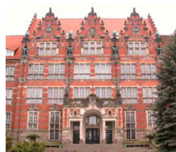
Elewacja frontowa Gmachu Głównego
