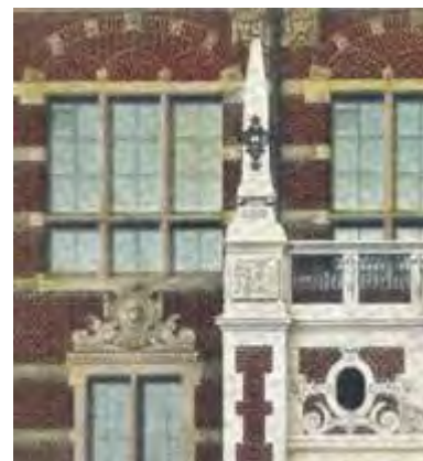
Neorenesans gdański z wpływami flamandzkimi – zbudowany ze specjalnie sprowadzanych śląskich materiałów: czerwonej cegły klinkierowej i białego piaskowca
