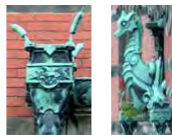
Detale miedzianych rzeźb elewacji bocznych
