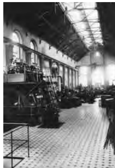
Wnętrze Laboratorium Maszynowego
