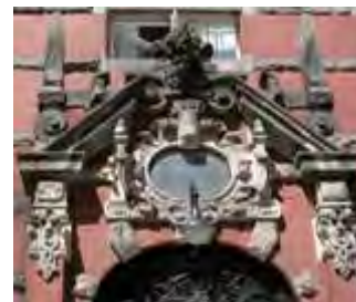
Wejście do Gmachu Elektrotechnicznego
