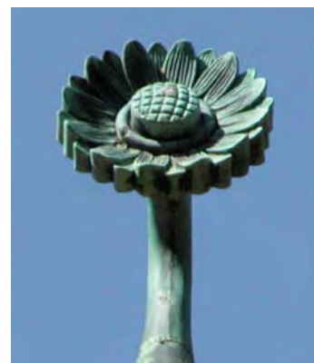
Miedziany kwiat umieszczony na szczycie klatki schodowej Gmachu Chemii
