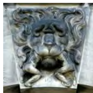
Detale przy głównej bramie od strony północnej
