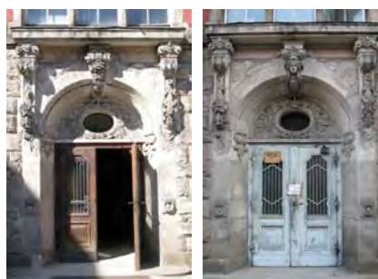
Wejścia boczne nr 1 i nr 2
