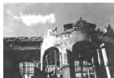
Zniszczenia Gmachu Głównego po marcu 1945 roku
