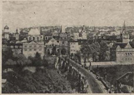
Widok na most Karola z wieżą mostową, kościoł i budowlę Starego Miasta. Z prawej za murem i drzewami odnoga rzeki „Mlýnský” — Most Karola
