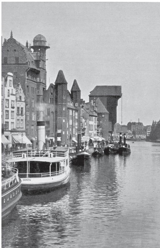
Abb. 12. Blick auf die Lange Brücke mit Krantor
