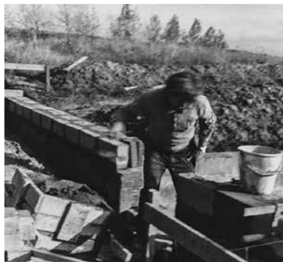
Henryk Lula przy pracy. Budowa pracowni w Brodnicy Dolnej
