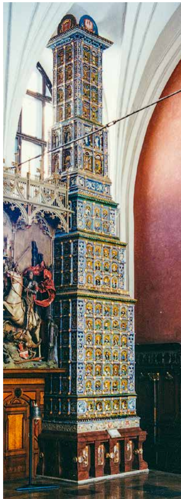
Piec po rekonstrukcji
