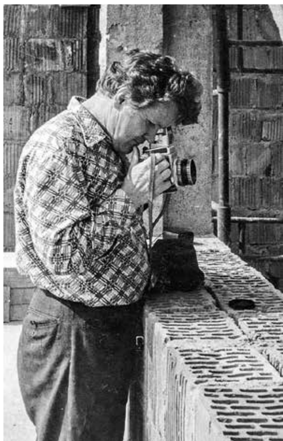
Henryk Lula na budowie pracowni w Brodnicy Dolnej, 1980
