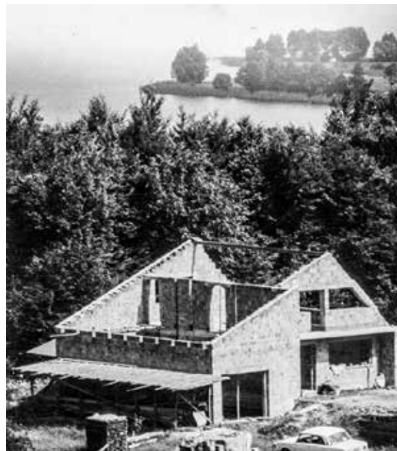
Pracownia w Brodnicy Dolnej w trakcie budowy
