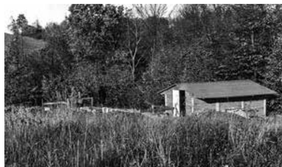
Budowa pracowni w Brodnicy Dolnej
