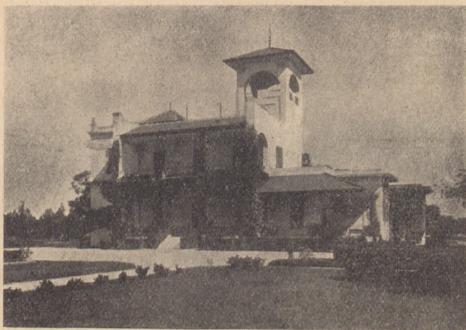
Ryc. 15. Typowy budynek estancji na pampie argentyńskiej.
