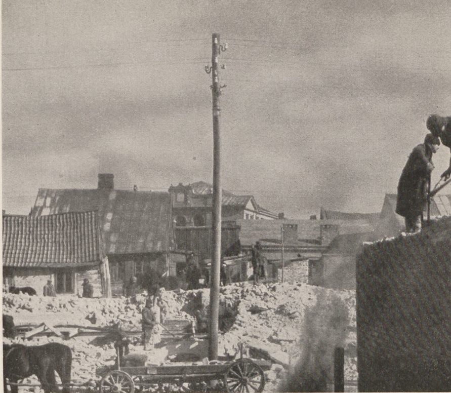
Das alte Zichenau während des Abbruchs
