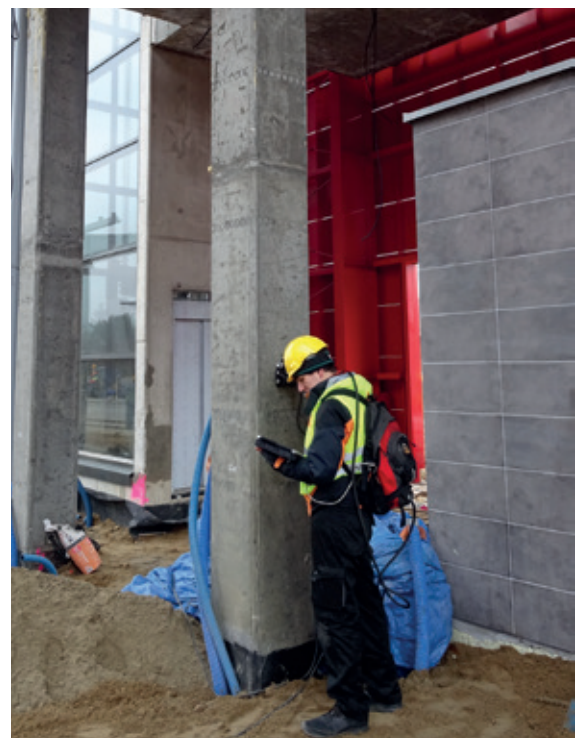
Monitoring konstrukcji inżynierskiej – pomiary terenowe
