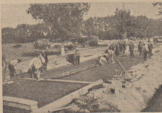
Droga państwowa nr 1 Bukareszt - Ploesti. Odcinek z asfaltu lanego.
