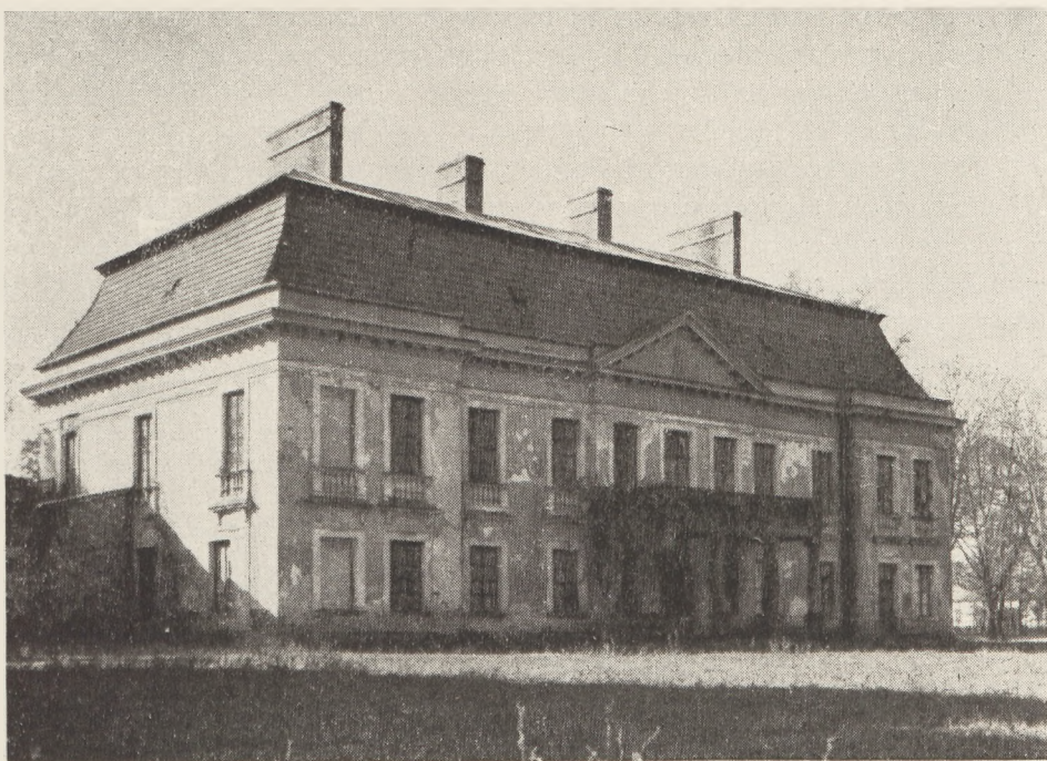
Ryc. 5. Pałac w Radziejowicach. Fasada północna. (Fot. E. Kozłowska).
