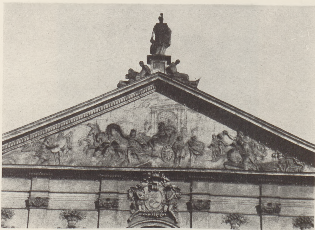
Ryc. 8. Górna część fasady pałacu Krasińskich od strony ogrodu.
