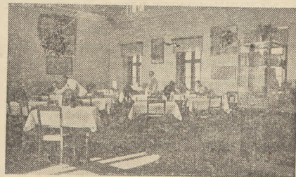
Wnętrze sali konsumpcyjnej restauracji KZG w Czechowicach
