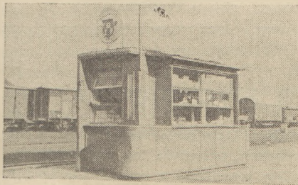
Kiosk KZG na peronie stacji Czechowice
