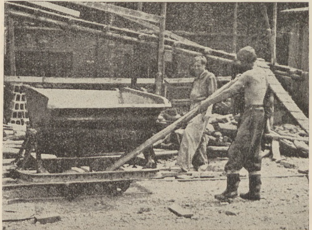
Rys. 8. Robotnik idzie obok wywrotki trzymając wolny koniec drąga do hamowania w ręku. Drugi idzie zawsze obok obok toru poza wywrotką.
