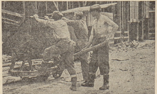
Rys. 3. Sposób obciążania ramy przy opróżnianiu koleby, gdy materiał jest lepki. Często jest on niewystarczający i robotnicy w celu zapobieżenia wyskoczenia wywrotki z toru obciążają platformę, stając na jej krawędzi. Jest to przyczyną niebezpiecznych wypadków.
