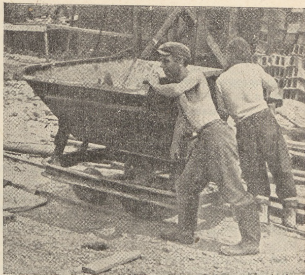
Rys. 9. Gdy uruchomienie jest trudne, należy z początku pomóc sobie przez podparcie jej ramieniem.
