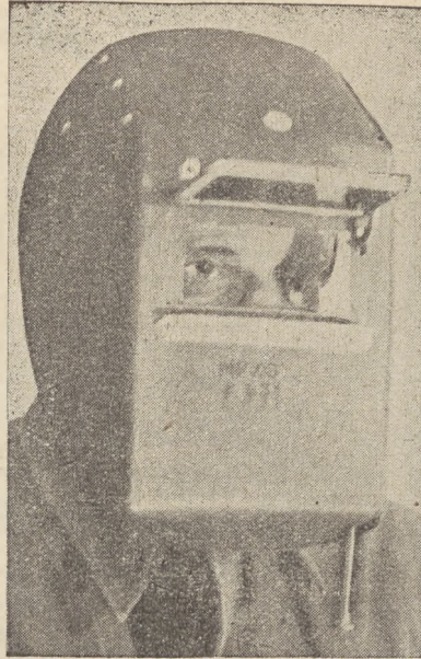
Rys. 1a. Osłona stała z uchylonym filtrem barwnym.
