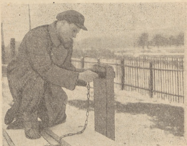
Rys. 2. Zabezpieczenie kłamry na kłonicie.
