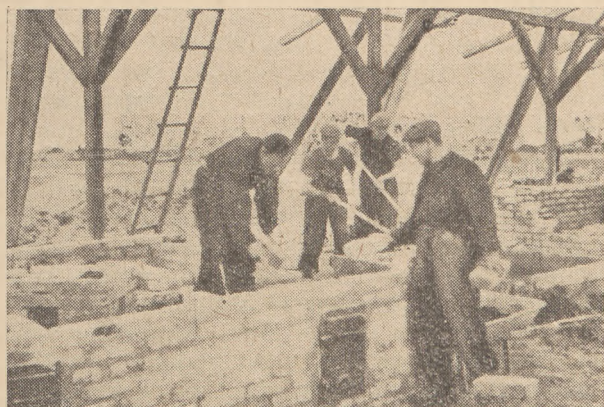
Budowa miasteczka złotowego na Rakowcu pod Warszawą.
