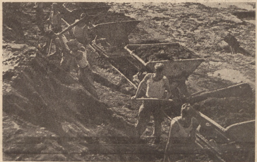
January 18 Brygady SP przy budowie autostrady Gdynia—Gdańsk.
