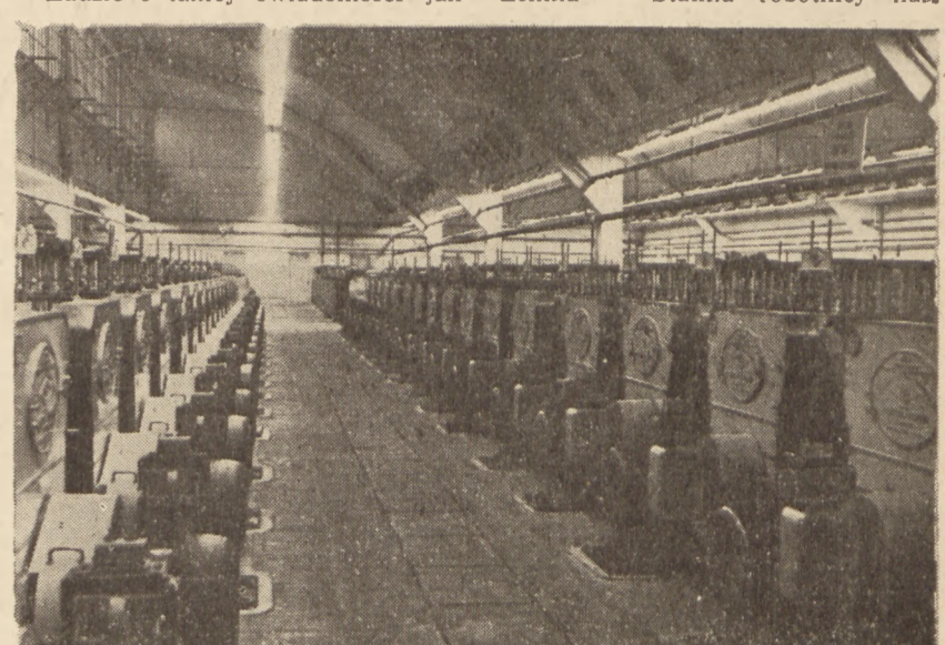
Hala silników samochodowych w Lublinie.
