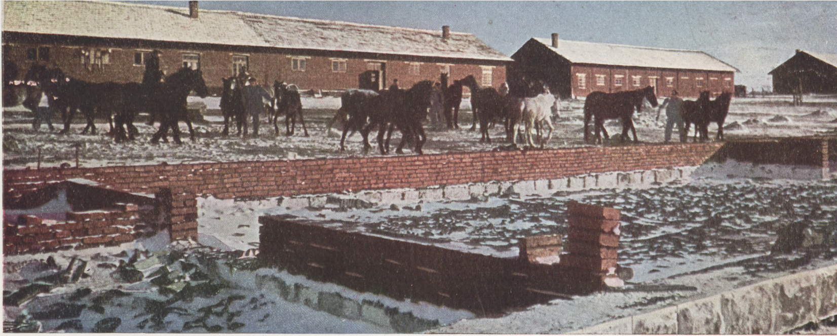
Каждый год на просторном кооперативном дворе вырастают новые постройки.
