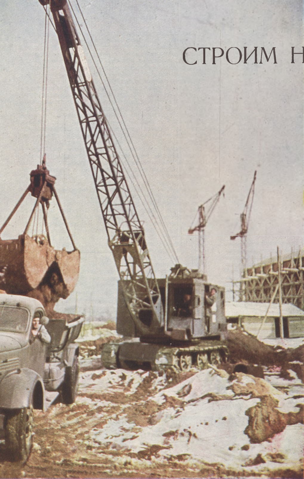
Большую часть строительных работ завода выполняют советские машины: экскаваторы, бульдозеры, подъемники, тягачи, катки и другие. При выемке грунта один экскаватор заменяет 24-х землекопов.
