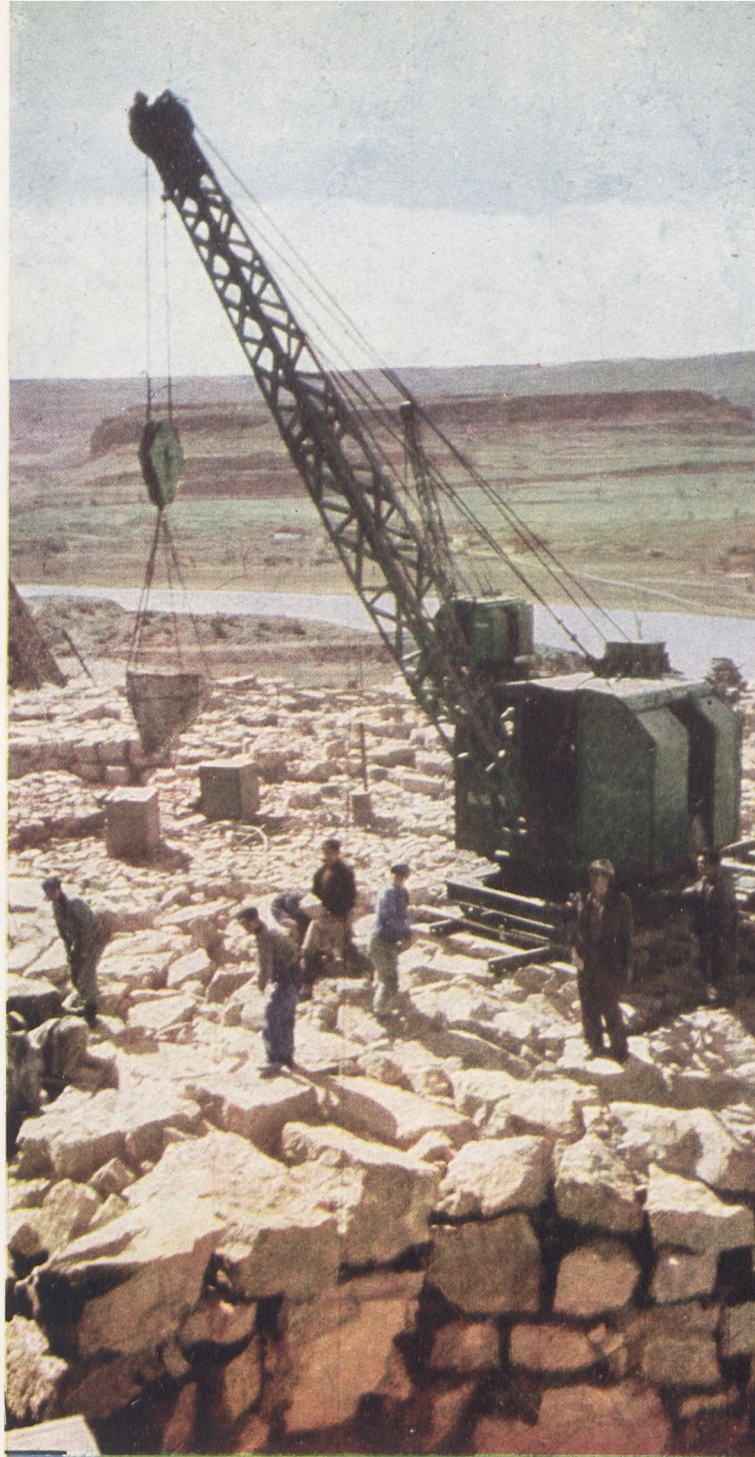
Строительство плотины проводится с помощью подъемных кранов, поднимающих каменные глыбы весом до 3 тонн.
