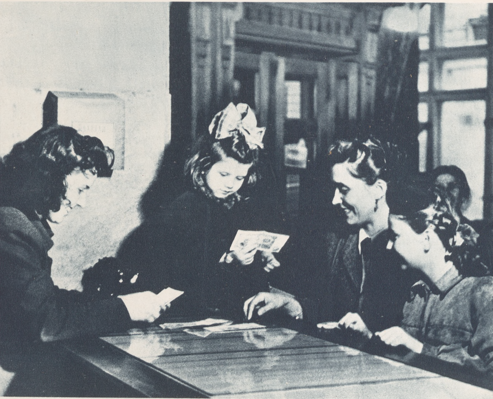
На следующий же день после опубликования постановления начался обмен денег. На снимке: обменный пункт № 56 Сталинского района столицы.
