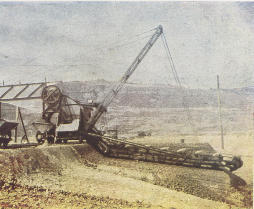
В песочном карьере работает экскаватор „Ралфа“ с машинистом Цветаном Рапковым. Экскаватором пользуются для снятия верхнего грунта в карьере.
