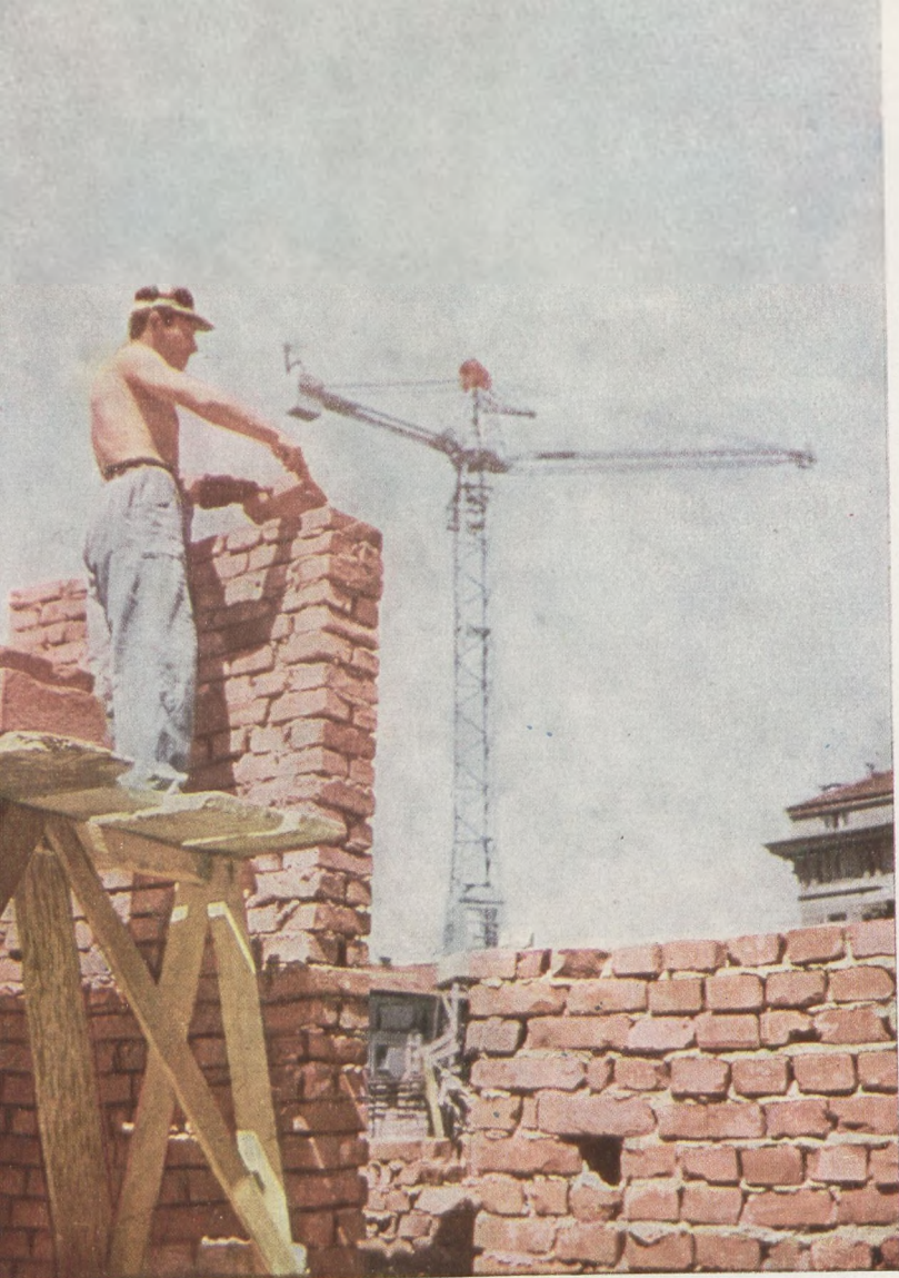
Закончив строительное училище, молодой каменщик работает на кладке стен.
