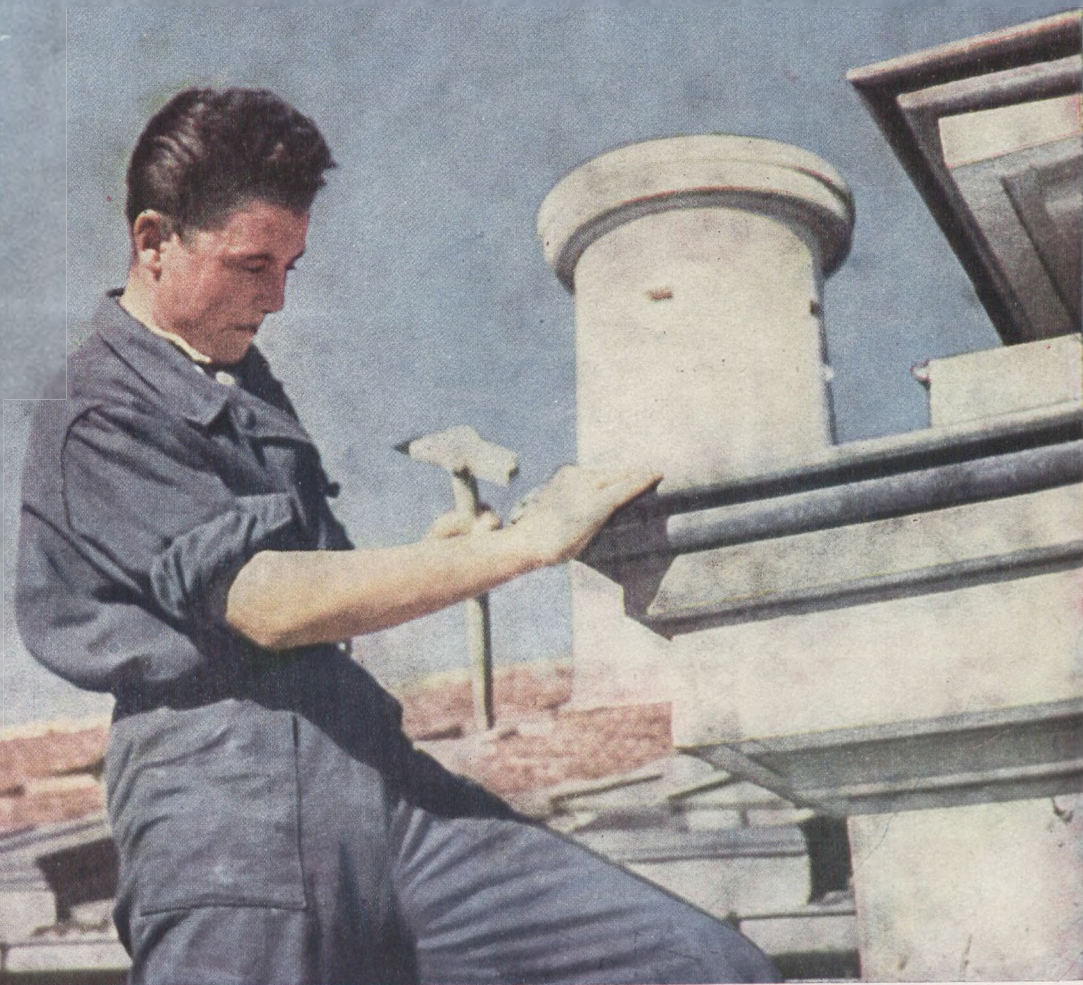
Боян Цветков, окончивший курсы при Стройобъединении в Софии, работает на стройке новой поликлиники.
