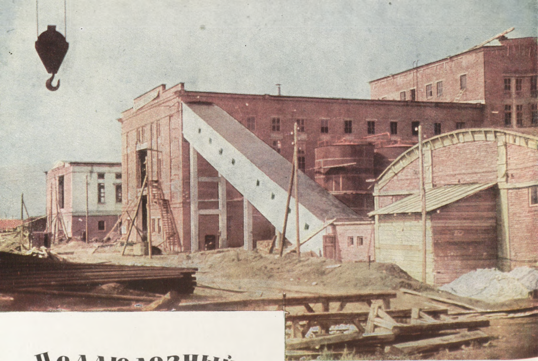
Вид стройки целлюлозного завода.
