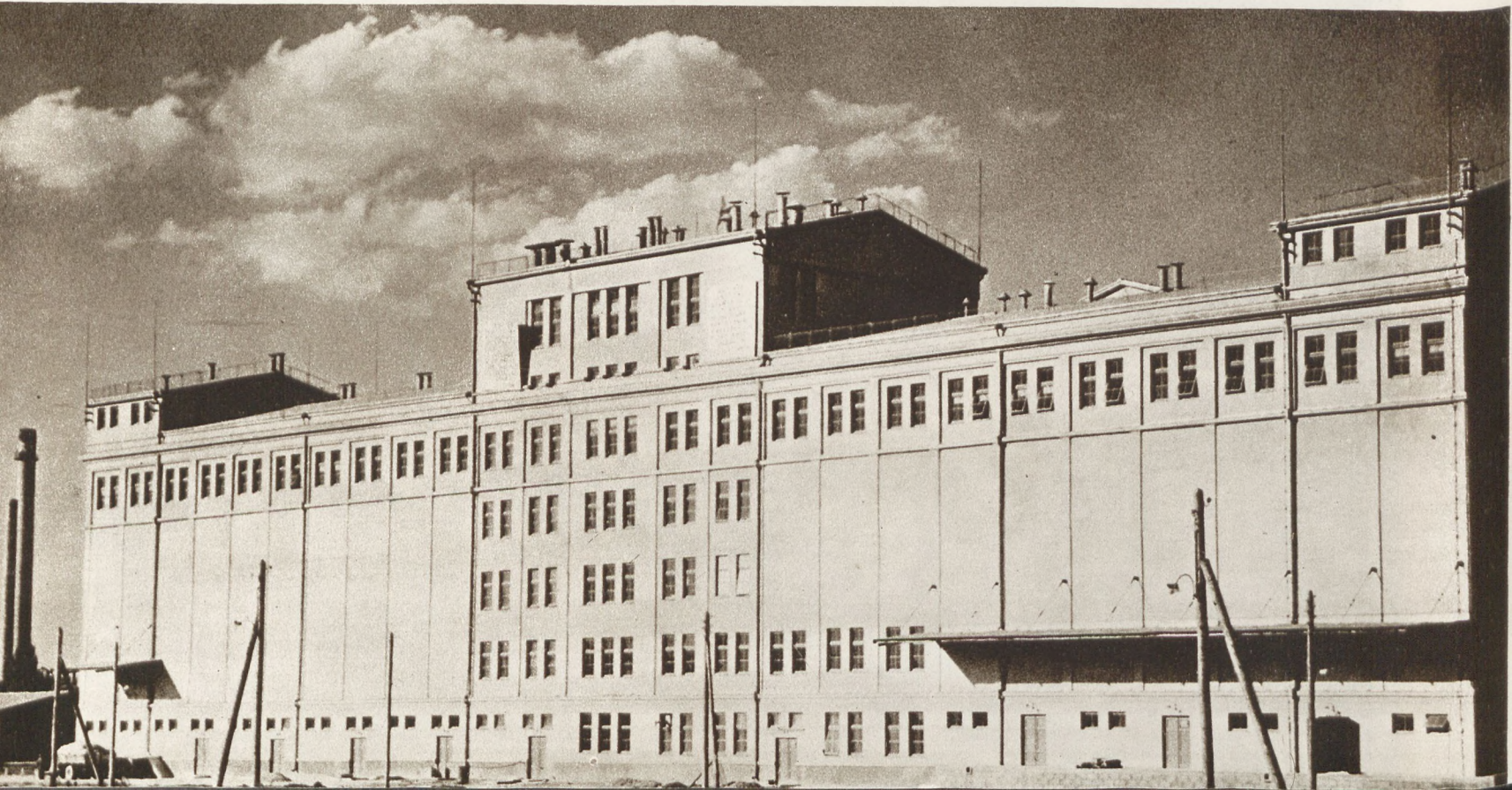
Здание фуражного комбината имени Кирова.
