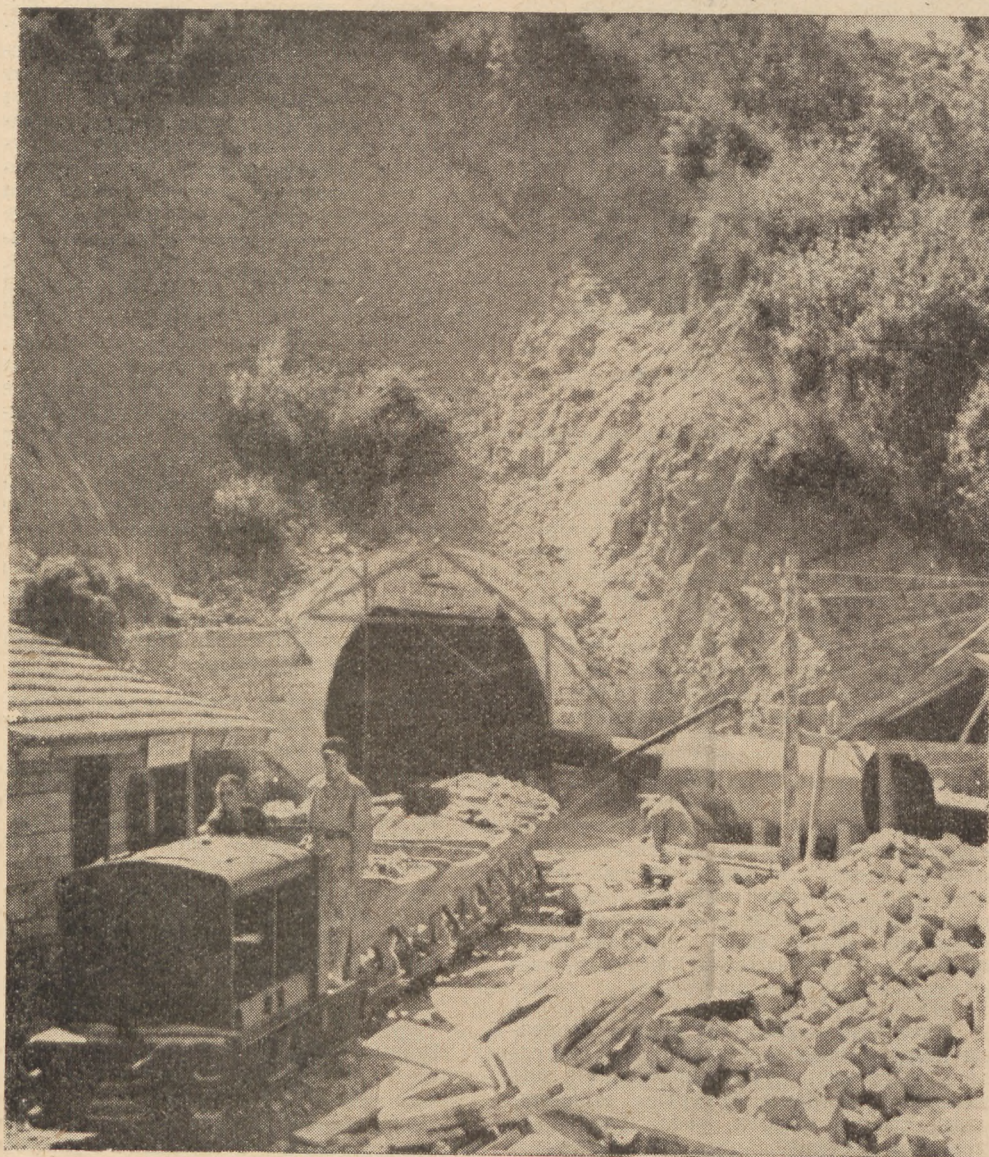
Вход в водонапорный туннель.
