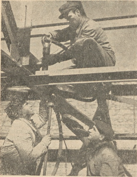
Бригада клепальщиков Ивана Царева клекает железную конструкцию прокатного цеха.
