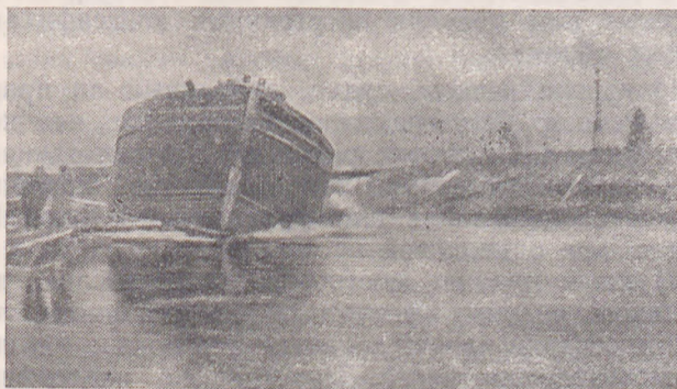
Спуск деревянной баржи с диагональной обшивкой для Ладожского озера, построенной на Сясьской судостроительной верфи из короткомерного леса в период Отечественной войны
