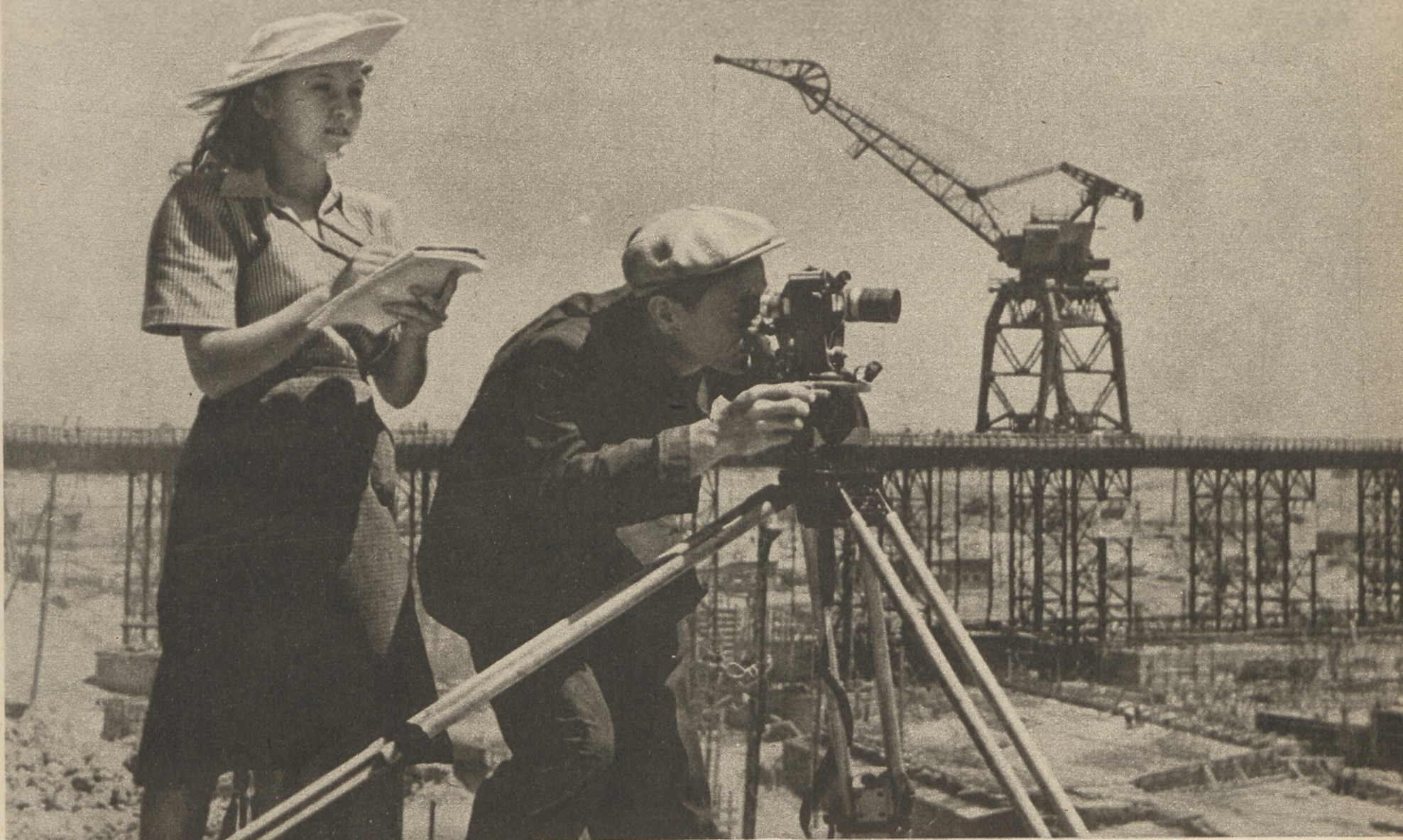
MŁODZI GEODECI RADZIECCY WIRIASOWA I GOŁOWANOW WYTYCZAJĄ OŚ WYKOPU PRZY BUDOWIE GIGANTYCZNEJ ZAPORY CYMLAŃSKIEJ.
