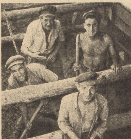
PRACE PRZY BUDOWIE KOLEKTORA
