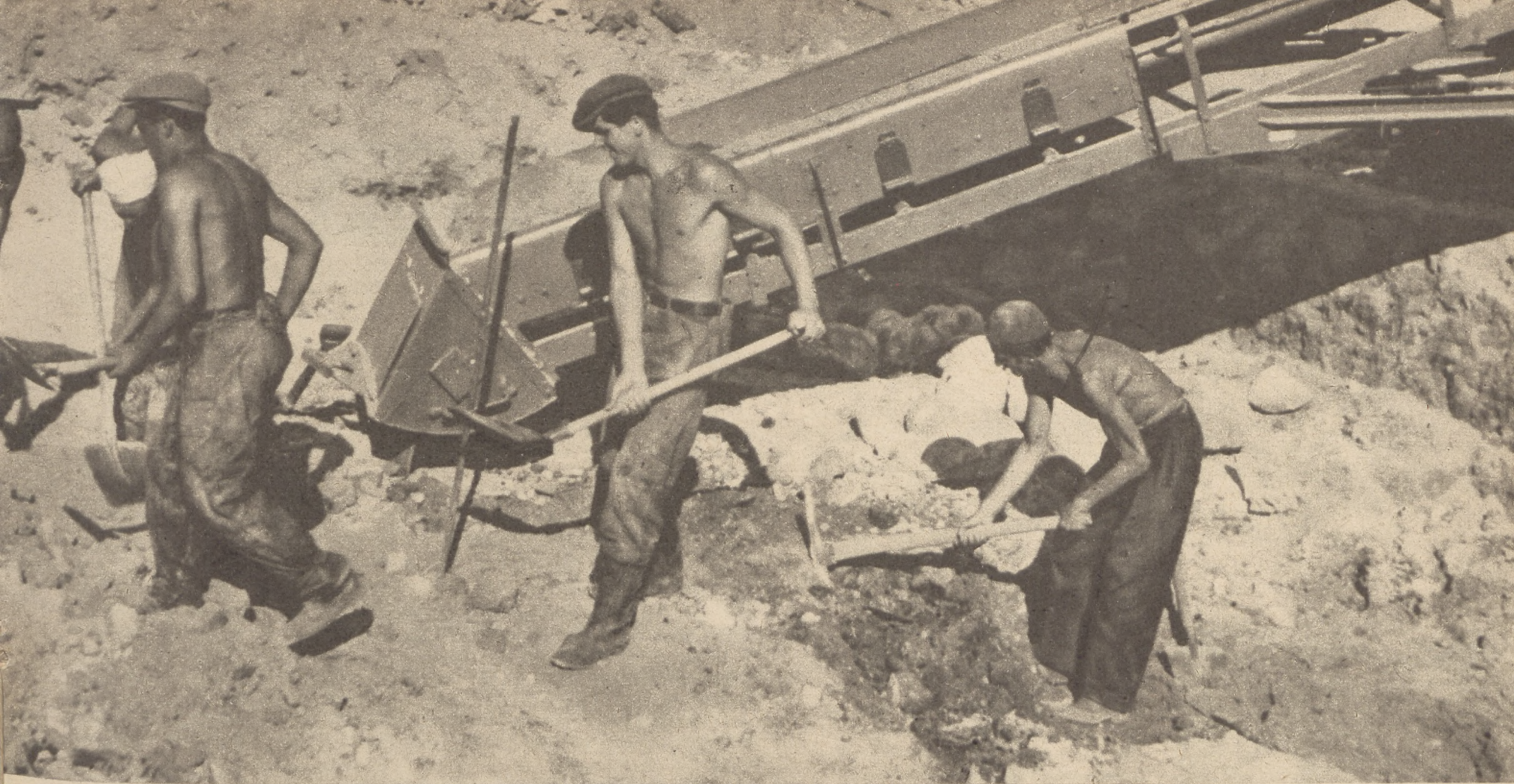
TRZY PRACOWNICY PRZEBIJAJĄ FUNDAMENTY STAREJ WARSZAWY, TORUJĄC DROGĘ SZYBKOBIEŻNEJ KOLEI PODZIEMNEJ. BRYGADA BODKA OSIĄGA 250 PROC. NORMY.
