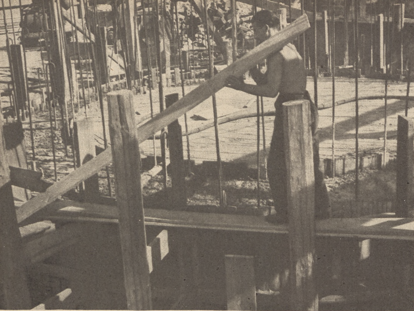
NÓŻ SZYBOWY DO KRAJANIA ZIEMI, ZBROJNEJ W BETON I STAL, WAŻY JUŻ STO TRZYDZIEŚCI TON.
