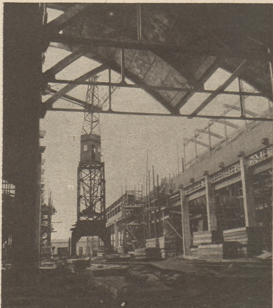
Hala Nr. 3 dopiero się rodzi. Potężny dźwig podnosi prefabrykowane części, z których montuje się dach. Tu pierwsze skrzypce grają jeszcze betoniarze.
