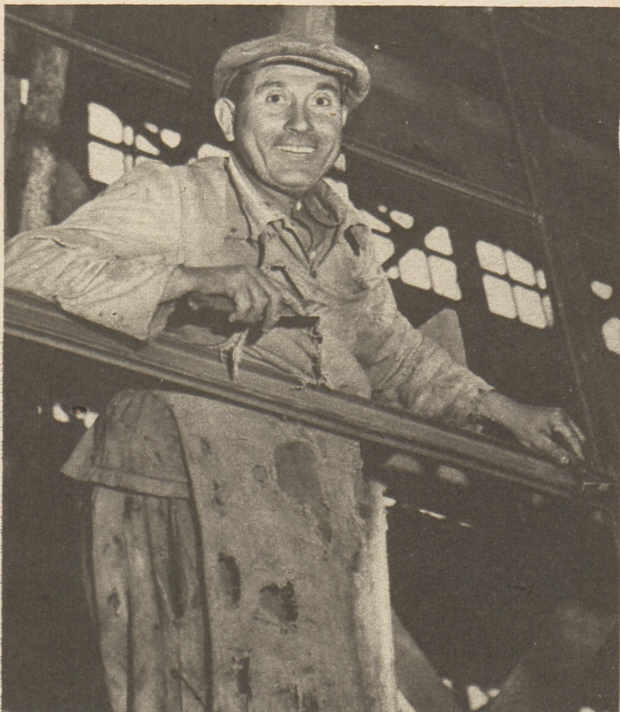
Stanisław Jaksak ze Zjednoczenia Budowlanego Nr. 3 szkli ścianki działowe w hali Nr. 1 i wykonuje przy tym systematycznie ponad 320 procent normy.
