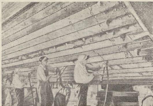
Рис. 2. Конопатка оконечности баржи старого типа на западном побережье США
