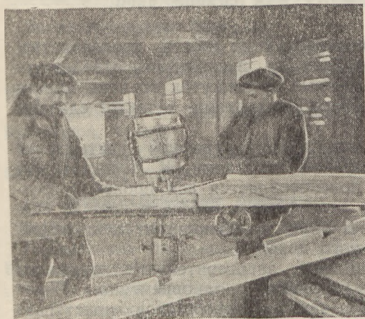
Рис. 3. Опыты по нарезке замков с зубом на станке Фролова
