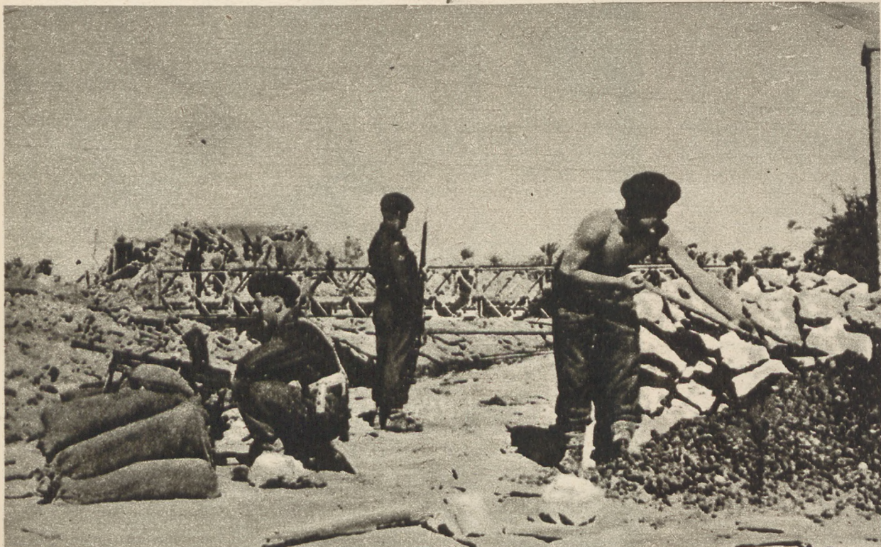
Dynamit torował drogę brytyjskim budowniczym „Alej Pegaza”. Czyż nie tak wyglądały ulice Warszawy w czasie roboty hitlerowskich „pegazów”
