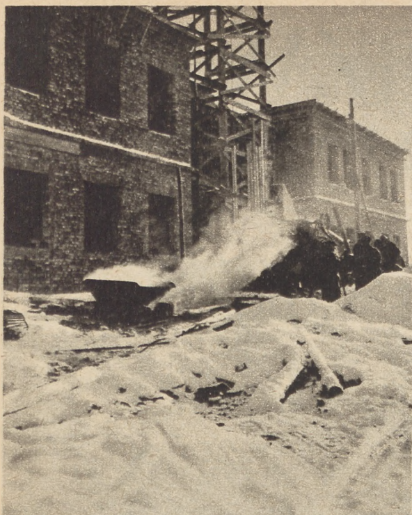
SUROWA ZIMA NIE WSTRZYMUJE BUDOWY.
