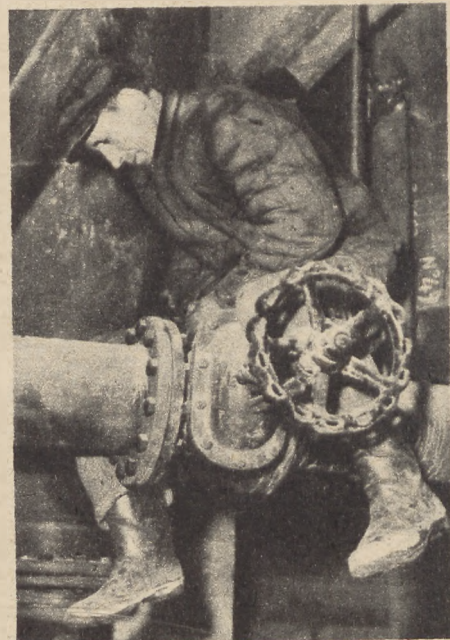
„Prędzej! Sprawdzamy zawory! — niecierpliwie się brygadziści Siwiec podczas montażu rurociągów do kolektora ssącego. Zespół montażowy coraz bardziej zwiera się i skupia, aby wykonać w terminie swe wcale nie łatwe zadania. Dotychczas idzie wszystko zgodnie z harmonogramem — ludzie Miechowic niewątpliwie dotrzymają słowa.
