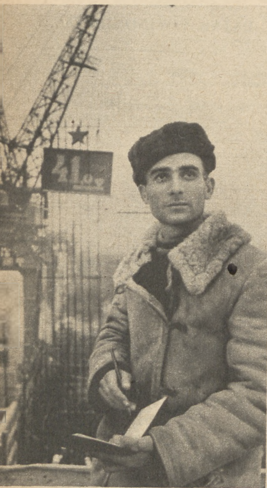
P. Koczerzenko, kierownik zmiany przy pracach oszaleniowych przy budowie Cymlańskiego węzła wodnego, jest jednym z tych, dzięki którym postępy prac na Wołgo-Donie wyprzedzają harmonogramy.
