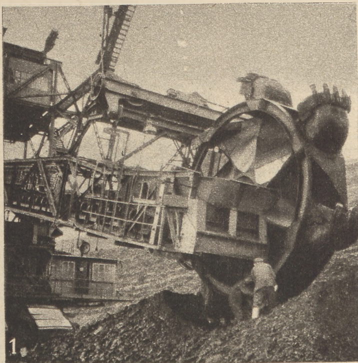
WAJĄCĄ SIĘ NA GĄSIENICACH, SAMA URABIA WĘGIEL BRUNATNY I NASTĘPNIE ŁADUJE GO NA PODSTAWIONE WAGONIKI KOLEJKI KOPALNIAŃEJ.
