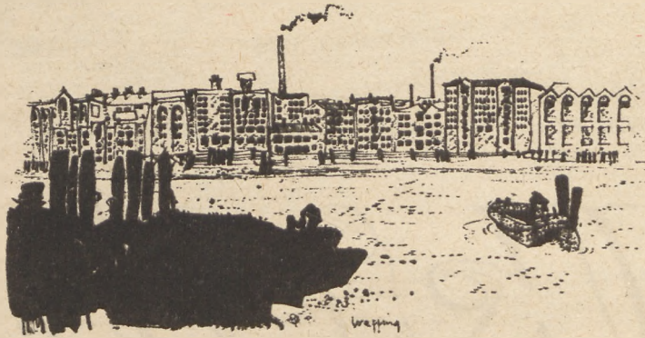
Stare magazyny nad Tamizą.
