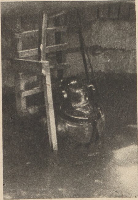
Do walki z niszczycielską wodą ruszyli nurkowie. Założyli oni keson podwodny, który umożliwił dalsze kontynuowanie robót nawet w zalanym wodą szybie.
