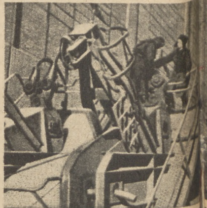
Demontaż koparki-giganta w zakładach. Dla przewiezienia tej maszyny...
