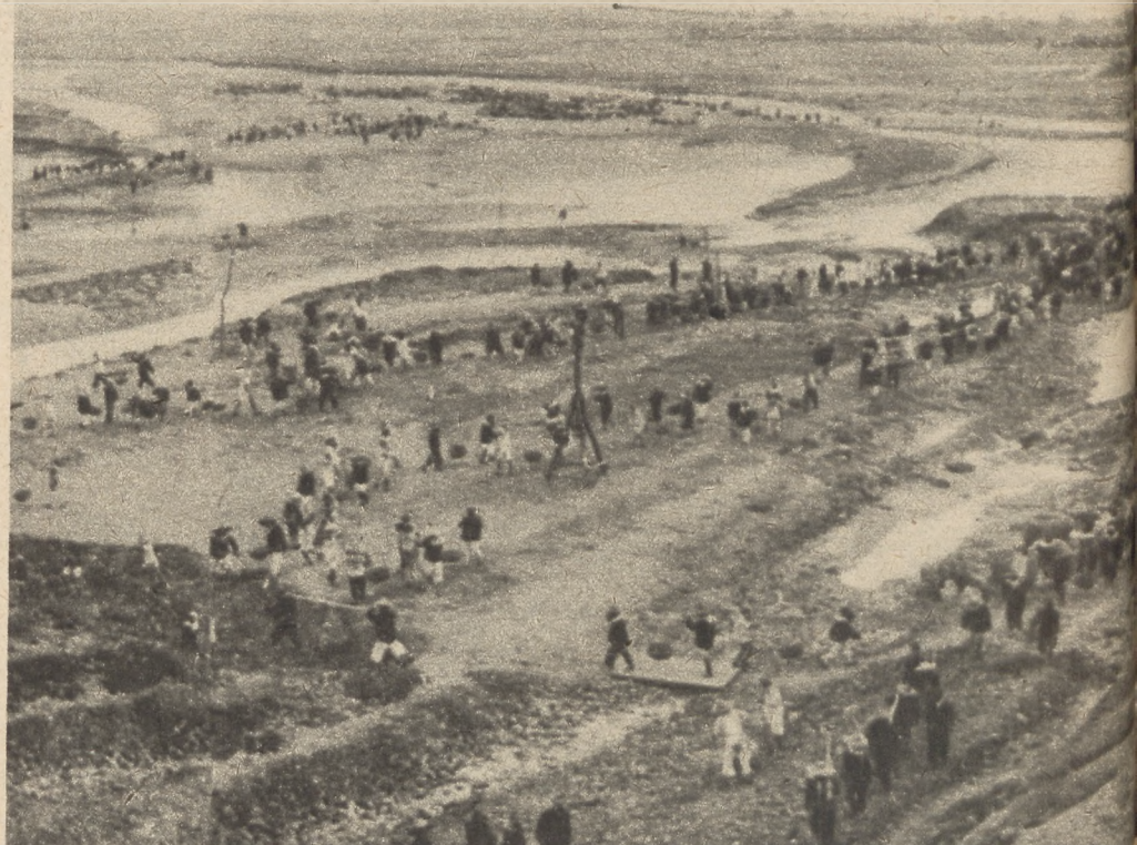
Naród chiński, pod wodzą Partii Komunistycznej podjął dzieło odbudowy zniszczonego i lat przeprowadzono gigantyczne roboty ziemne, wśród których jedną z najpoważniejszych
