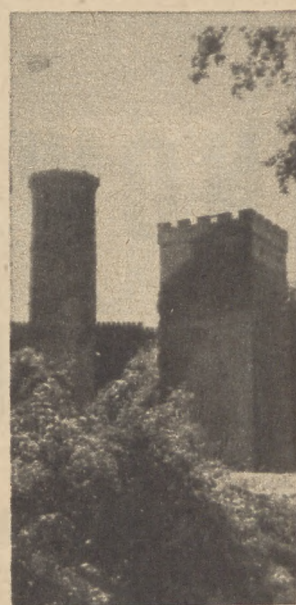
Ruiny Zamku, widok na baszty obronne
