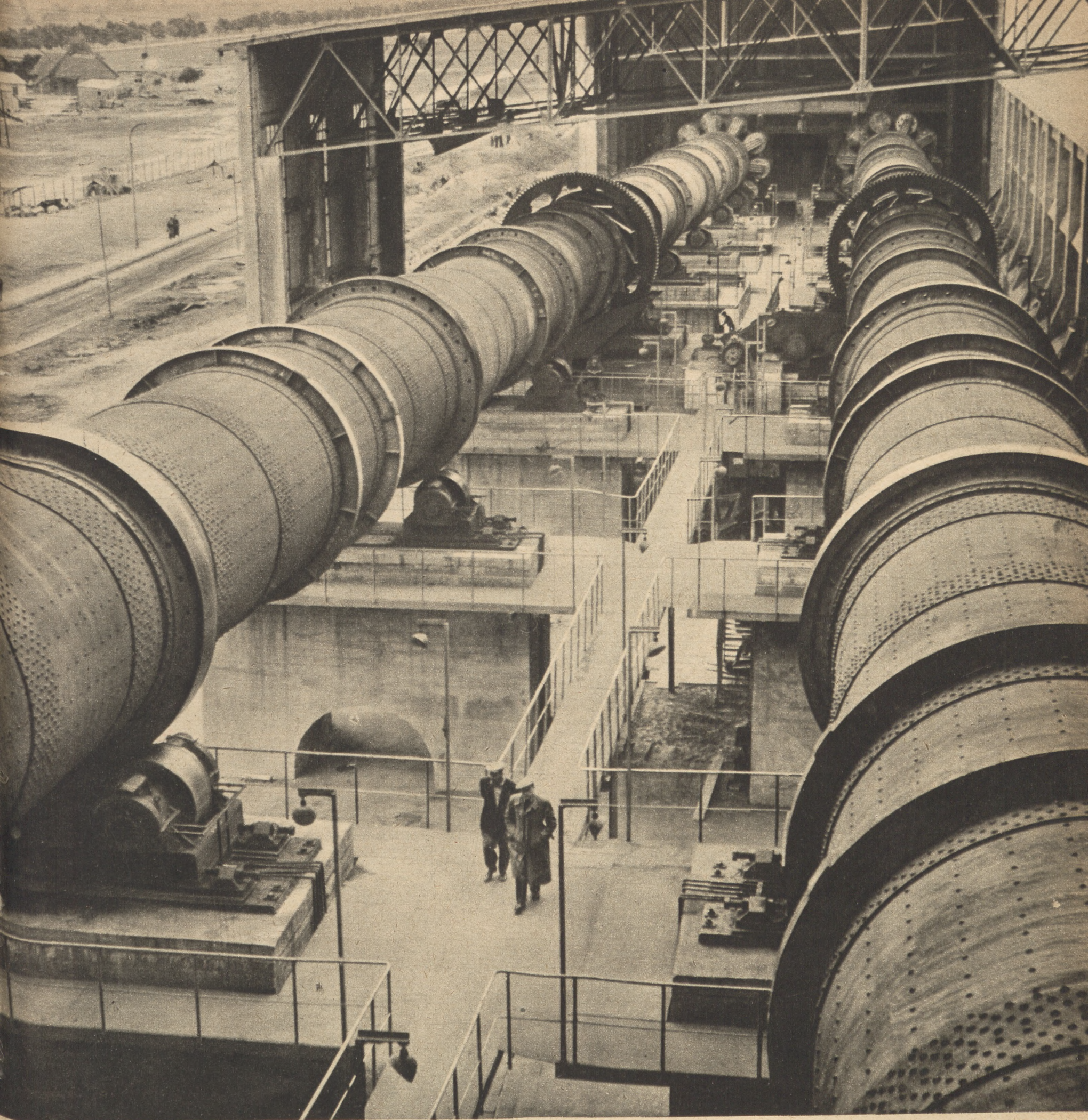
...ocześniejszych w Europie. Dozorowane przez ośmiu ludzi obrotowe piece-giganty wypalają rocznie tysiące ton klinkieru, podstawowego materiału do produkcji cementu.
