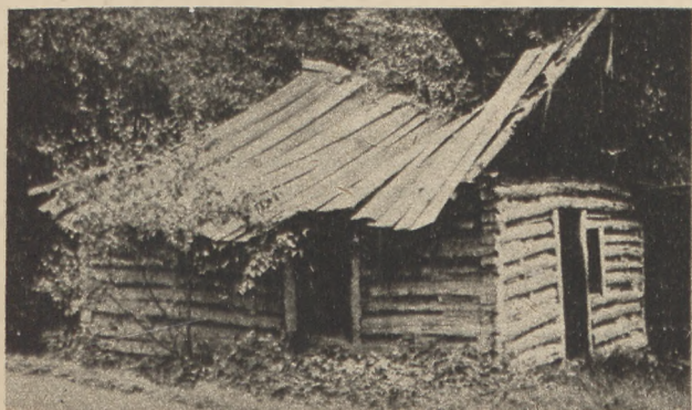
W niedźnych pomieszczeniach pracowali kiedyś w Sułkowicach kowale-chatupnicy.
