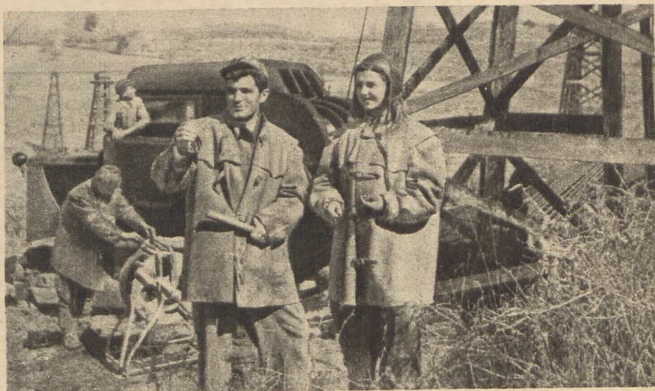
Kierownik czołowej brygady wiertaczy, Veli Allaibe, w rozmowie z młodziejką Kristiną Vechi, kierowcą ciężkiego ciągnika, obsługującego teren budowy.
