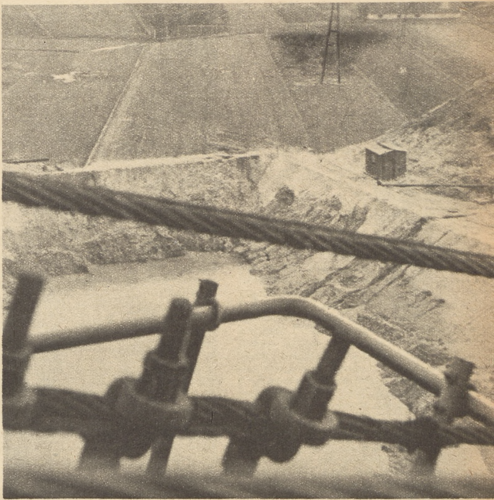
Dół ten wykopała w ciągu dwu tygodni jedna koparka, wykonująca pracę 600 robotników. Równocześnie maszyna odrzuciła wybraną ziemię na odległość 75 m.
