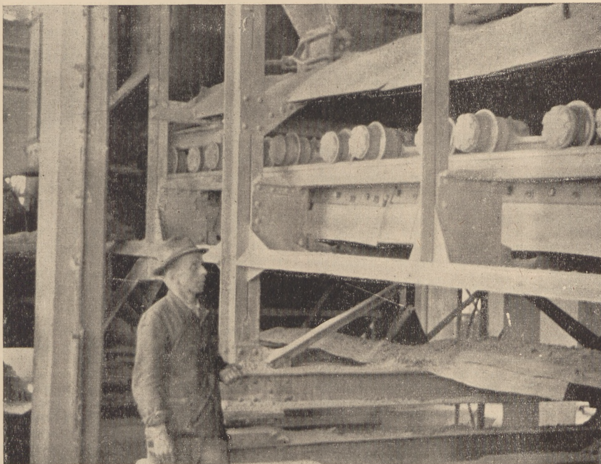
Piec rusztowy do wypalania klinkru. Posuw wózków rusztowych (odwróconych do góry dnem) w kierunku transportera z mieszanką. Po powrocie do normalnego położenia zostają one napełnione warstwą klinkru — jako podkład. Na podkład następnie dowożona jest automatycznie mieszanka mąki surowej i koksu
