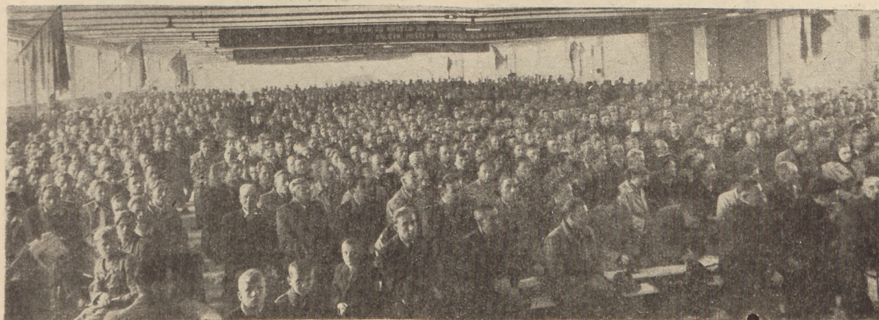
Wielka hala cementowni Wierzbica podczas uroczystości uruchomienia fabryki.
